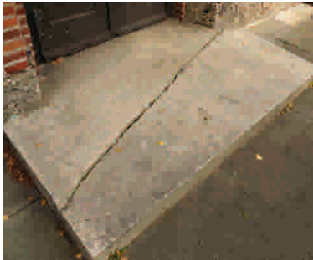
Defekte Eingangsstufe
